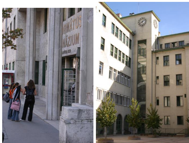
A Lónyay Gimnázium 1943-ban átadott épülete ma, amelyet ideiglenesen 1955 – 1973 között a ÉKME, illetve BME Közlekedési Kara , 1973 – 2000 között a Közgazdaságtudomány Egyetem használta.
